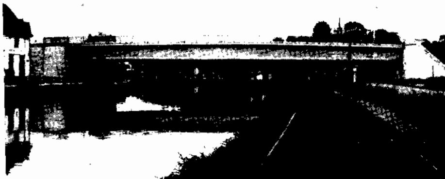
Fig. 4. — Puente del Hipódromo.- Lille.- Francia.
