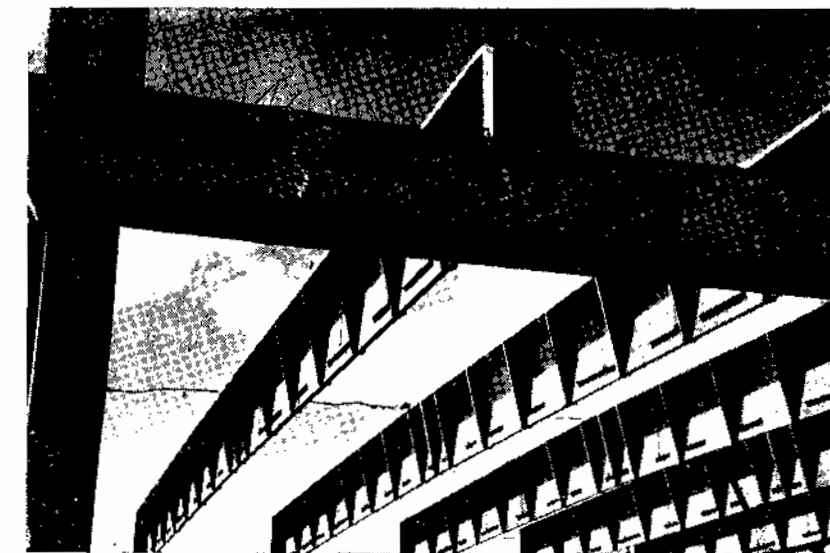
Fig. 13. - Hangar en el Aeropuerto de Londres.
